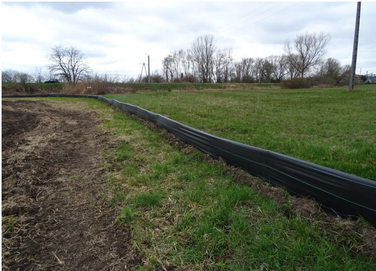
Fot.5 Przykład zastosowania na terenie Inwestycji płotków herpetologicznych pełniących jednocześnie funkcję wygradzania siedlisk przyrodniczych.
