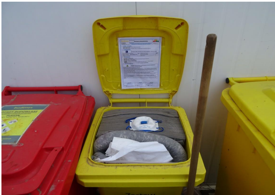
Fot.3 Wyposażenie zaplecza budowy w pojemniki z sorbentem oraz matami sorbentowymi.
