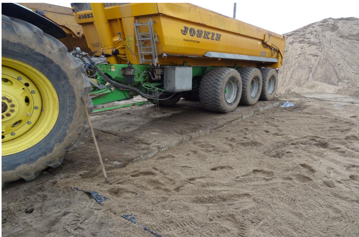
Fot.6 Utwardzenie miejsc do parkowania maszyn za pomocą foli oraz płyt.
